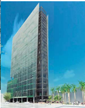
ホーチミンのブルマンホテル（工事中）
