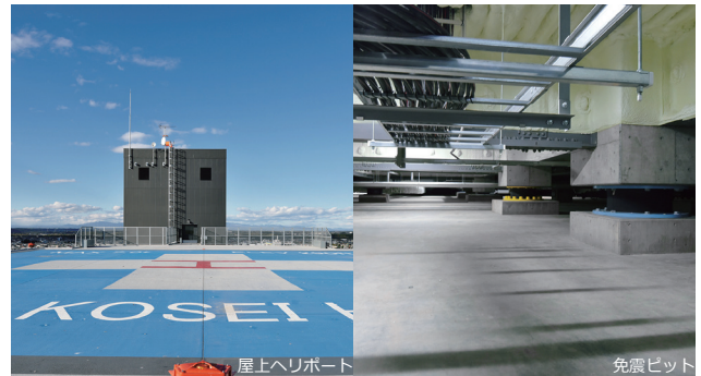
屋上ヘリポート
