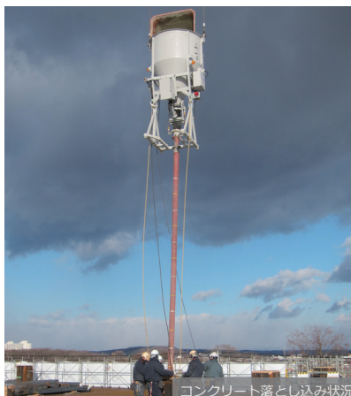
コンクリート落とし込み状況
