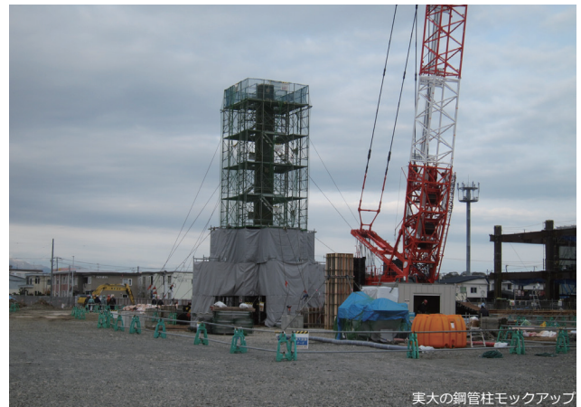
実大の鋼管柱モックアップ
