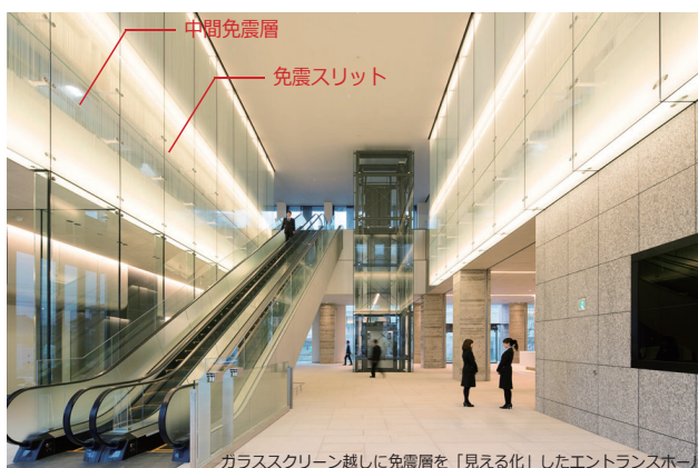
ガラススクリーン越しに免震層を「見える化」したエントランスホール
