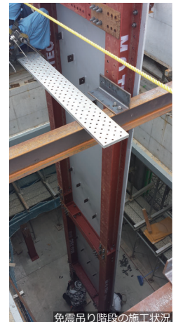
免震吊り階段の施工状況
