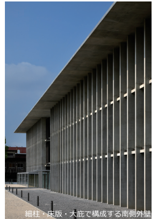
細柱・床版・大庇で構成する南側外壁
