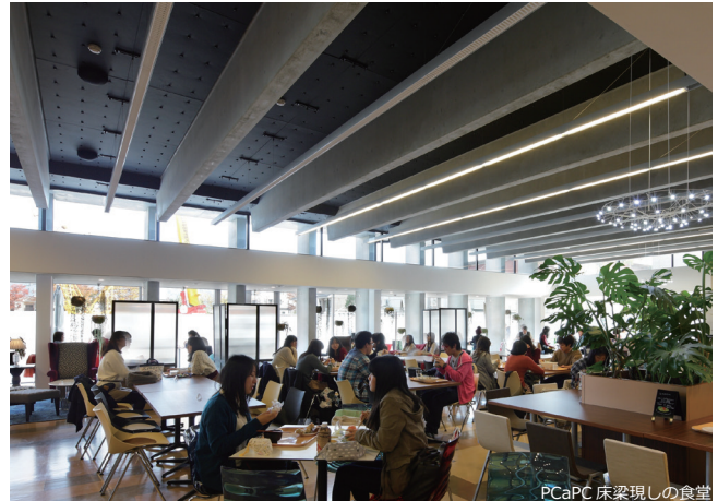
PCaPC 床梁現しの食堂
