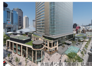
赤坂通り側（南側）低層部
