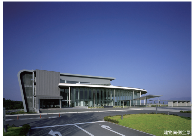
建物南側全景
